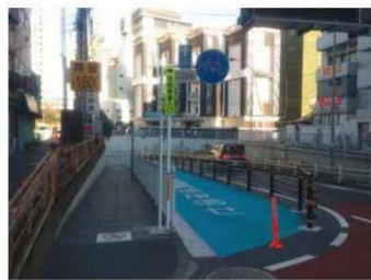
図16-1 自転車道 (出典：安全で快適な自転車利用環境創出ガイドライン)
