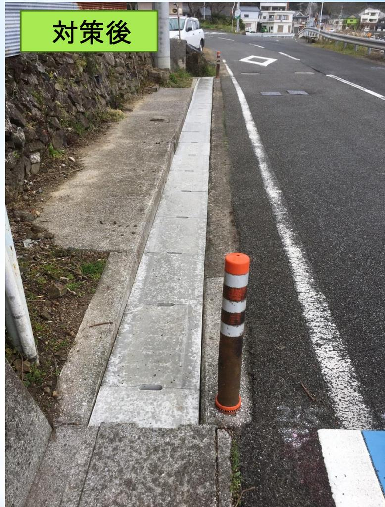
側溝にコンクリートの蓋ができ、通行できる足場が完成しました。雨でも水が流れるように側溝の清掃を行い、石や草なども取り除いています。安全に通行できるようになりました。
