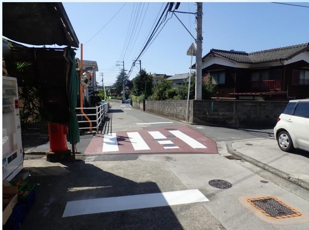
交差点部を**カラー化舗装**し、**横断歩道**、**停止ライン**を引き直した。視覚的に横断歩道を認識しやすくするとともに、ドライバーの減速の意識も高める効果が期待できる。児童に対して引き続き指導を行い、横断歩道の安全な通行を目指したい。
