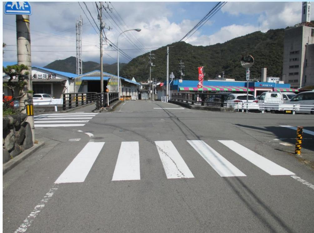
児童の通行方向に合わせて新たに2つの横断歩道を設置しました。ガードポールを見えやすくしたり、新しい標識を3方向から見えるように設置し、ドライバーが視覚的に認識しやすくなりました。
