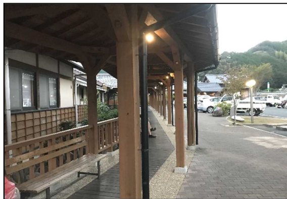
写真 1.8 屋外施設(回廊)
