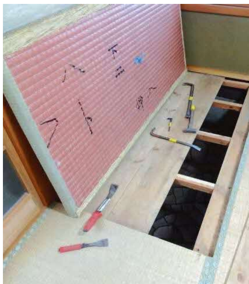
和室の床板をはがす (写真①)
