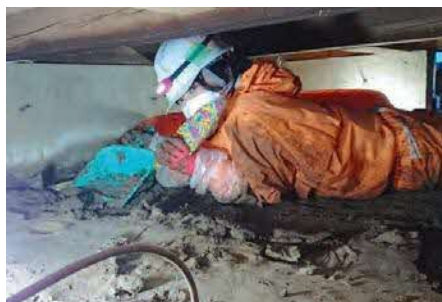
床下の泥だしの様子
