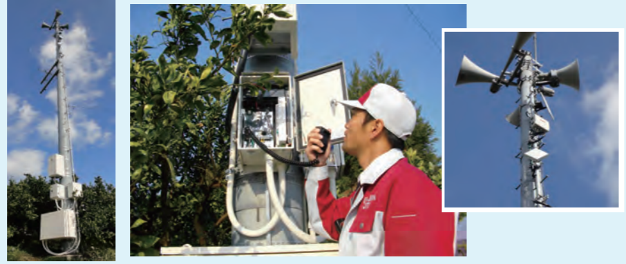
屋外拡声子局/防災共用型放送設備(地区放送連携、アーケード連携)
