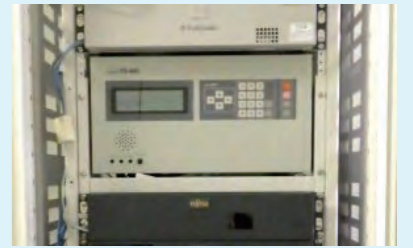
多回線音声応答装置 緊急時(災害等)放送及び定時放送を聞き逃した場合に、電話で放送内容が確認できる装置です。 防災行政放送テレホンサービス 電話 0895-49-7064
