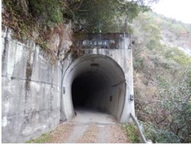
梨ノ木谷隧道
