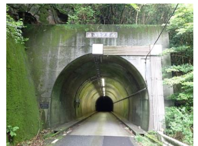
篠山トンネル
