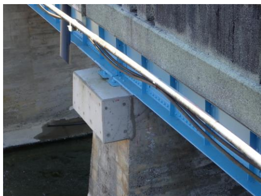
図8. コンクリート補修
