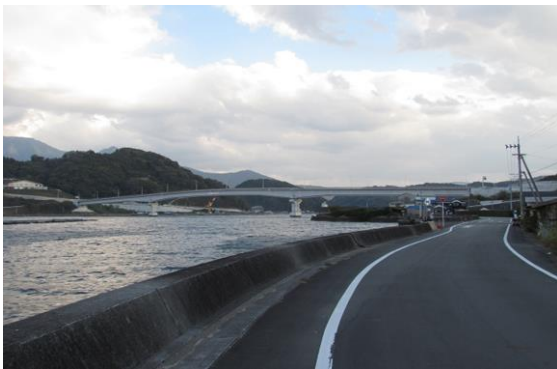
図 1. 九島大橋（橋長 468.0m）
