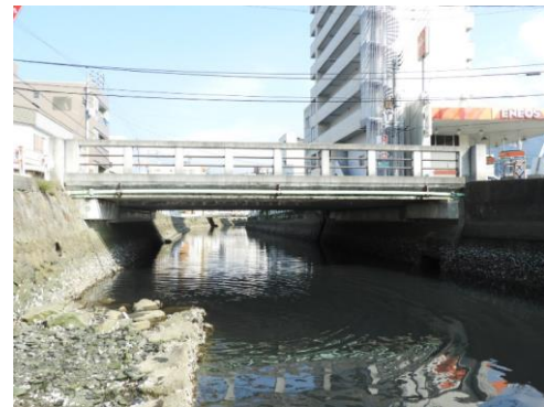
図 2. 天神西橋（橋長 12.6m）
