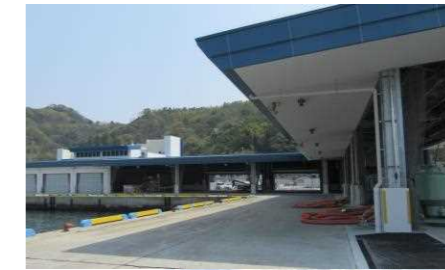
庇(ひさし) 日光や雨を遮り、水産物の品質低下を防ぐ。
