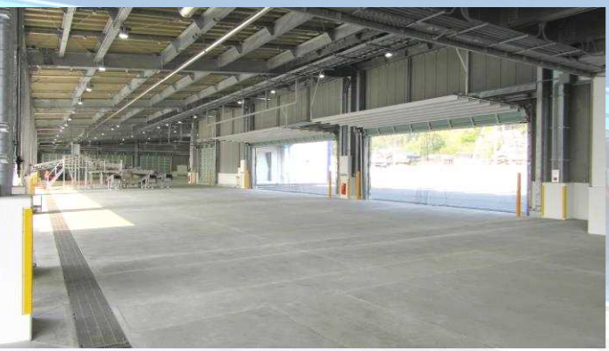
荷さばき室2 スペースを広く取り、作業場所と動線を確保
