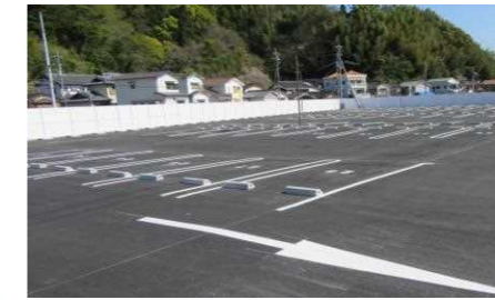
駐車場を囲う防音壁 車両の騒音を低減
