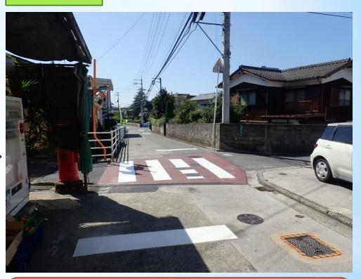
交差点部をカラー化舗装し、横断歩道、停止 ラインを引き直した。視覚的に横断歩道を認識 しやすくするとともに、ドライバーの減速の意 識も高める効果が期待できる。児童に対して引 き続き指導を行い、横断歩道の安全な通行を目 指したい。
