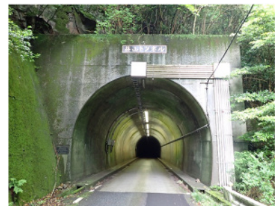
篠山トンネル
