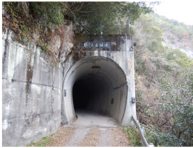
梨ノ木谷隧道
