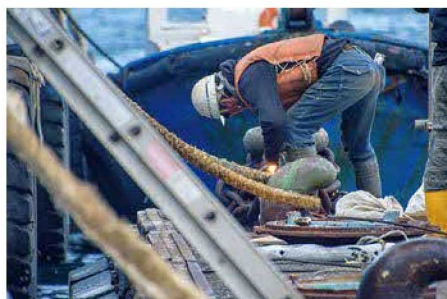
栈橋の改修工事 / @koki_photos.7200
