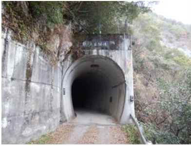
梨ノ木谷隧道
