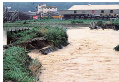
昭和63年梅雨前線豪雨による被害 (写真：愛媛県提供)
