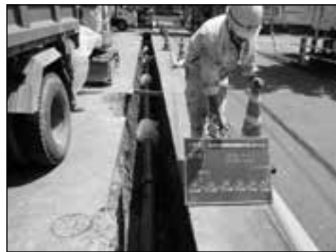
▲第7次整備 耐震直送管を布設
