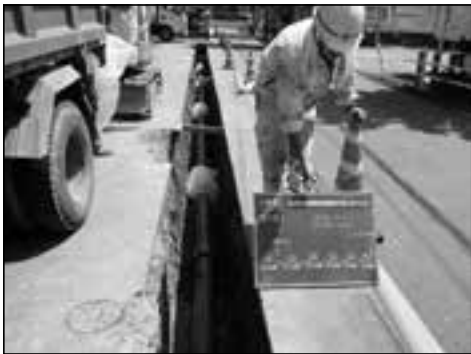
▲第7次整備 耐震直送管を布設
