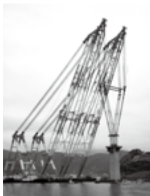
(橋脚設置工事の様子)
