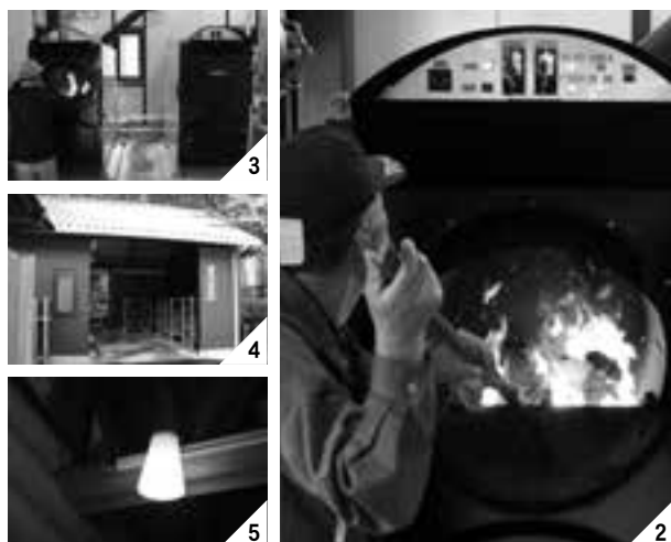
1) 祓川温泉外観 2) ボイラに薪を投入する様子 3) 薪ボイラ 4) ボイラ室の外観 5) LED化した本館の照明器具 6) 燃料の薪
