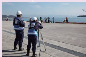
【港湾施設被害調査】
