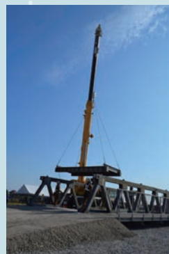
【応急組立橋設置】
