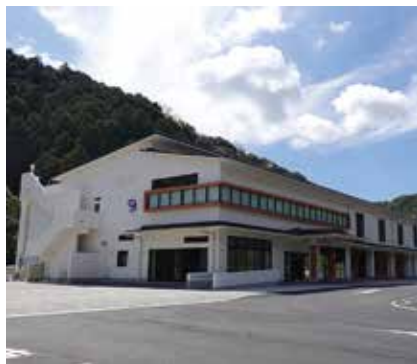
▶道の駅津島熱田温泉整備事業
