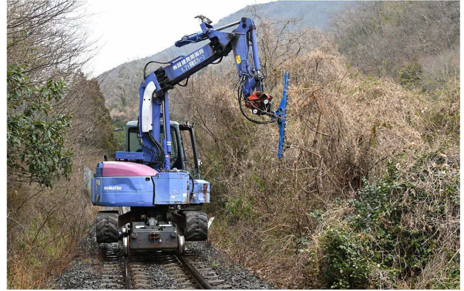
バックホウによる沿線樹木伐採
