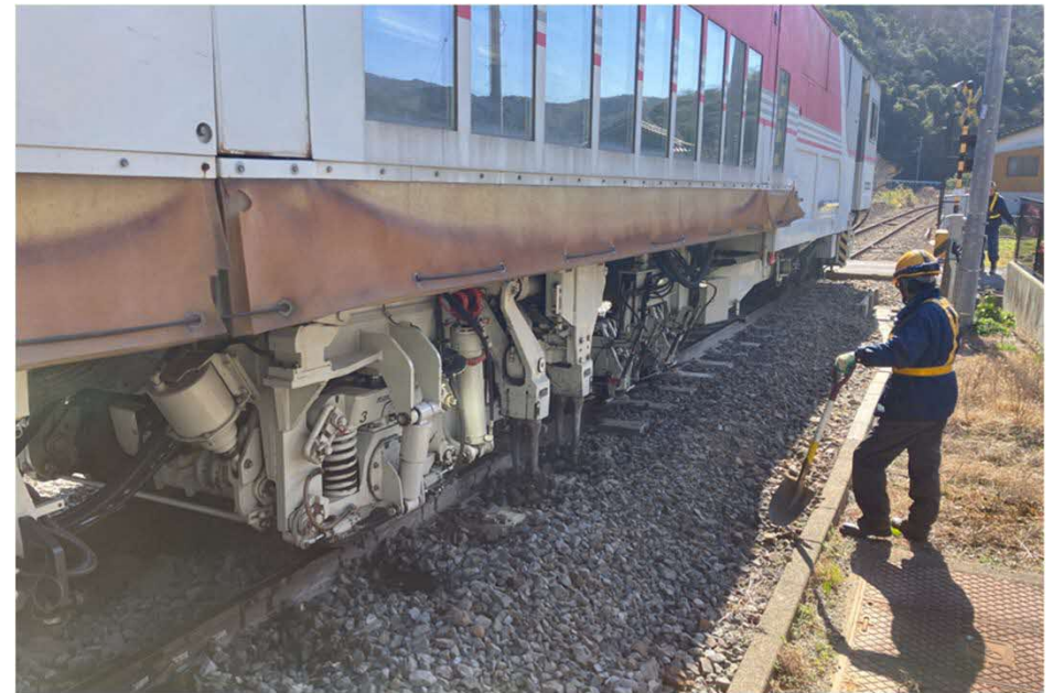
大型保線機械による軌道整備
