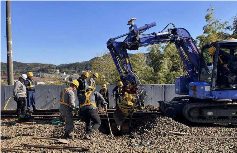
バックホウによるマクラギ交換
