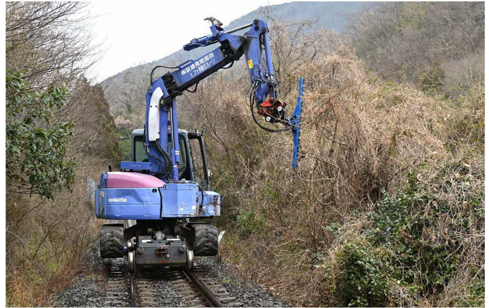
バックホウによる沿線樹木伐採
