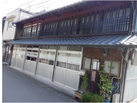
江口邸・敷地高（本通り）
