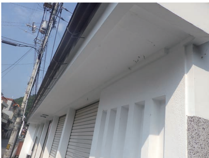
小野邸・1階漆喰調塗籠（本通り）
