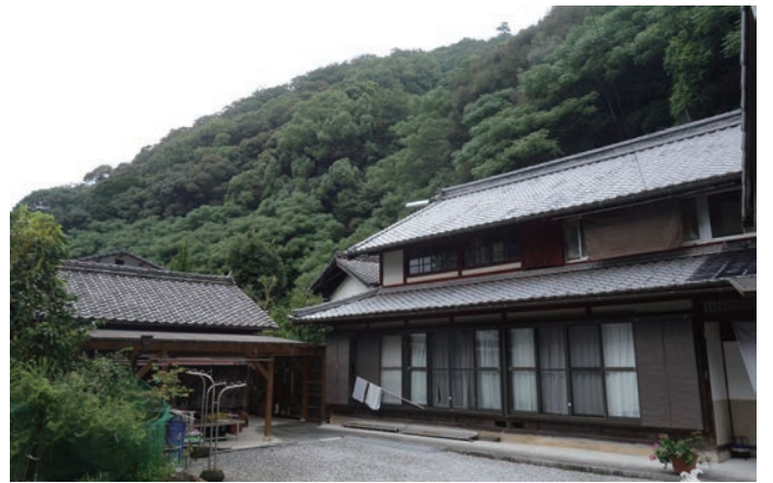
土居ノ奥の伝統的建造物の屋根形状
