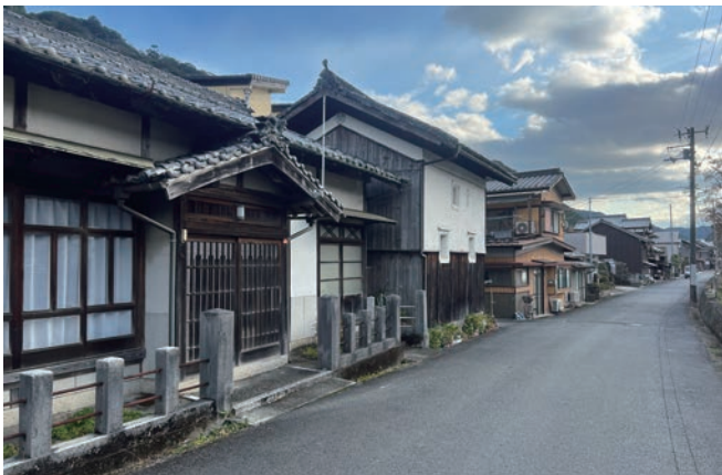
川通り・浜通りの平屋建て・2階建ての伝統的建造物
