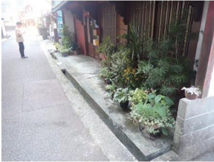
峰邸・敷地高（本通り）
