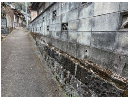
土居ノ奥の擁壁部分の処理
