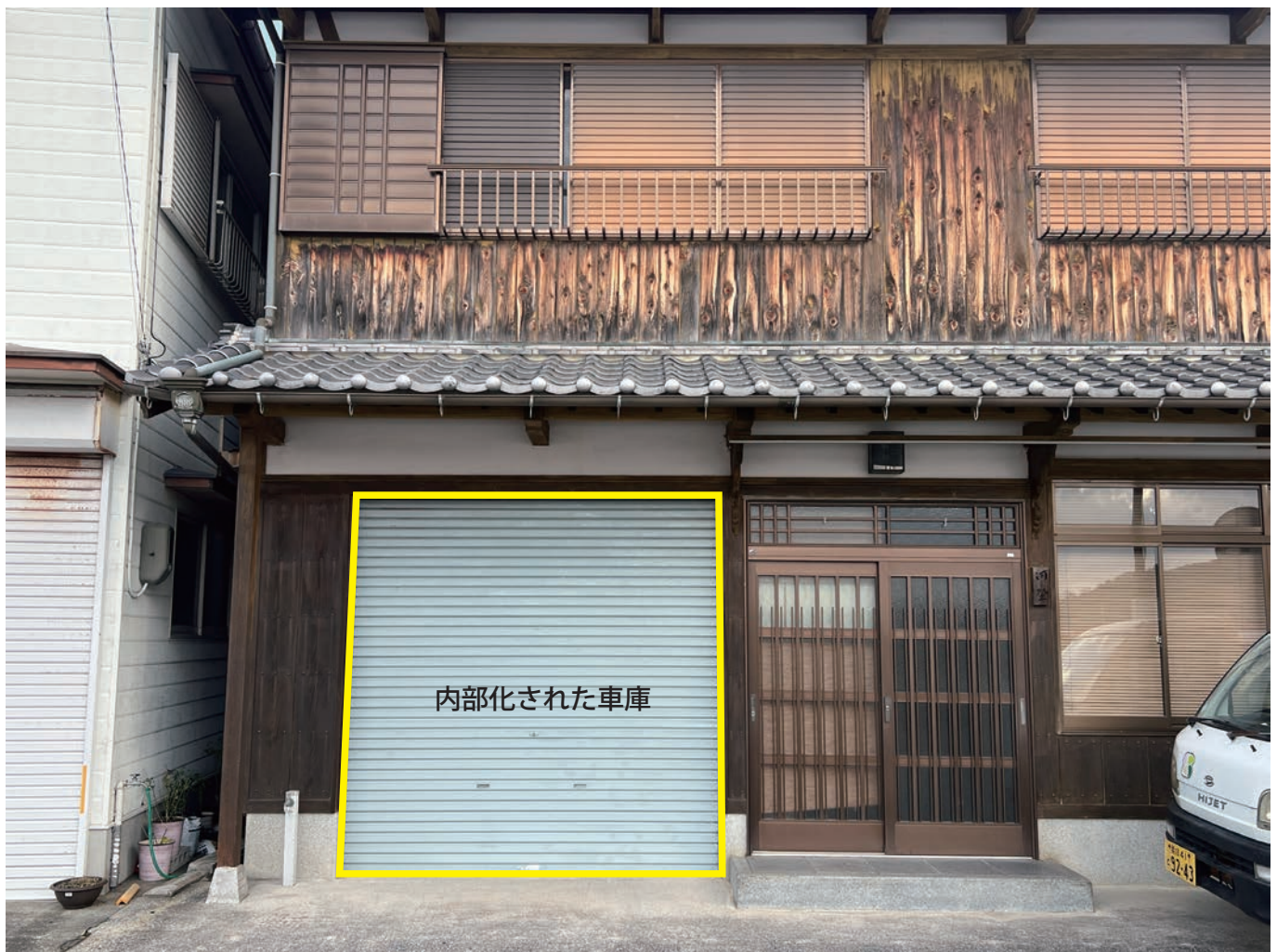
河野邸・スチールシャッター（港町）
