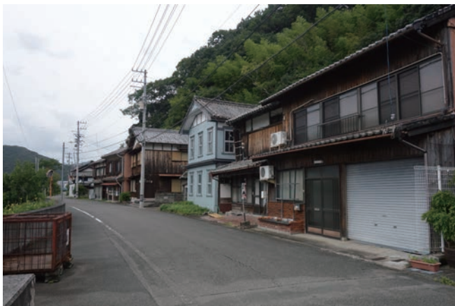
港町の伝統的建造物の屋根形状
