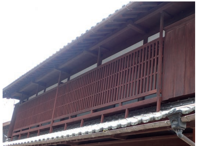
阿部邸・2階出桁、腕木（本通り）
