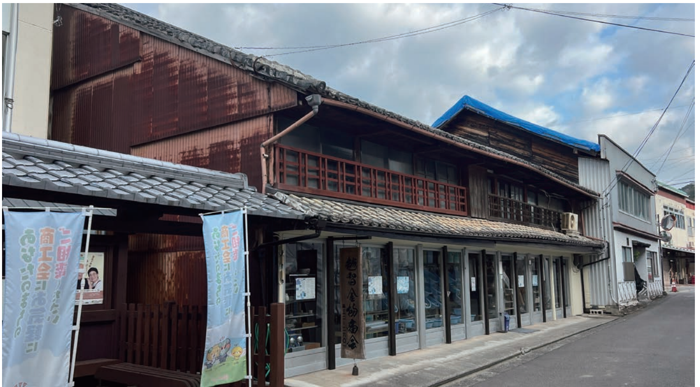
越智邸の修景後の外観
