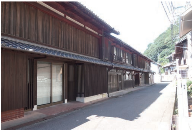
本通りの伝統的建造物の屋根形状
