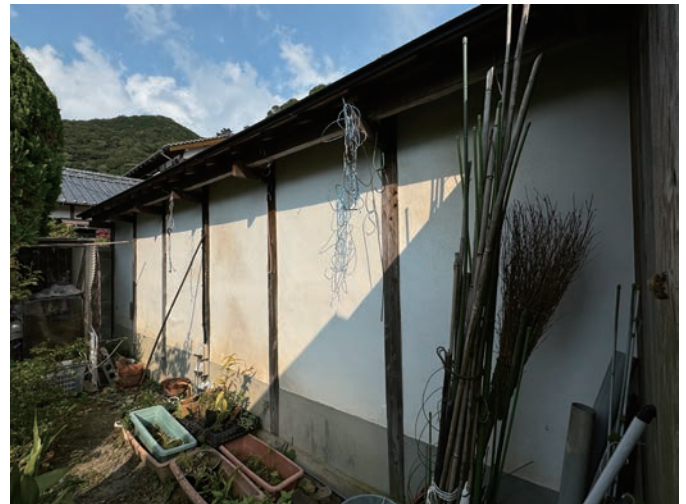
福山邸・漆喰塀（中道）
