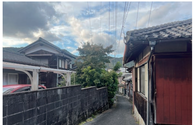
土居ノ奥の平屋建て・2階建ての伝統的建造物
