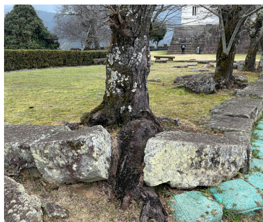
サクラで損壊している本丸の建物跡
