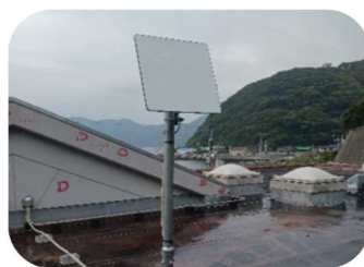
日振島出張所にアンテナを設置
