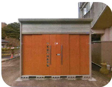
備蓄倉庫の設置
