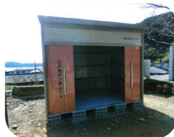
備蓄倉庫の設置
