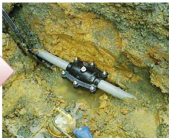
▼ 袋ジョイントによる継手補強
