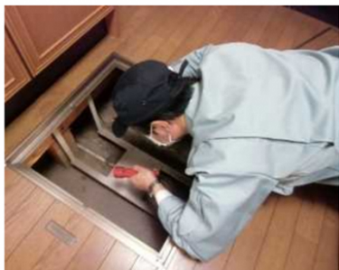
「土台・床組、基礎」調査の様子
