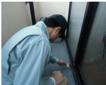
「外部（バルコニー）」調査の様子
