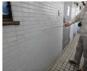
「外部（外壁）」調査の様子
