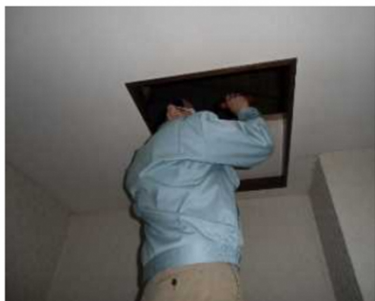
「小屋組・梁」調査の様子
