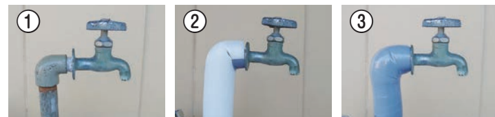
① 露出している蛇口 ② 保温チューブを巻く ③ 外装テープを巻く
