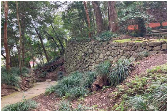
井戸丸北側石垣
