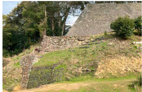
修理した石垣
