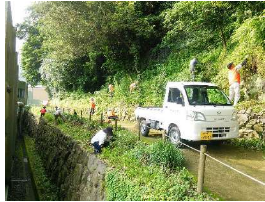
植栽地での維持作業（除草）
