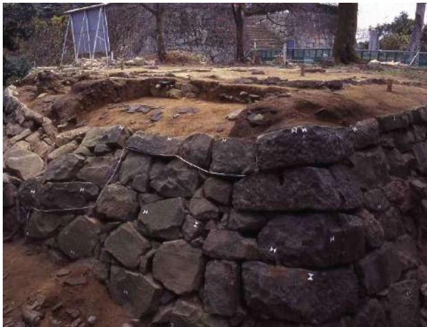
二之丸御算用矢倉下の幕末期の石垣：損壊後盛土や積み足しによって修理
