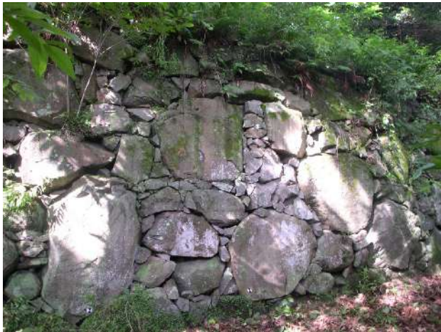
煙硝矢倉へ至る城道沿いの鏡石を多用する石垣
