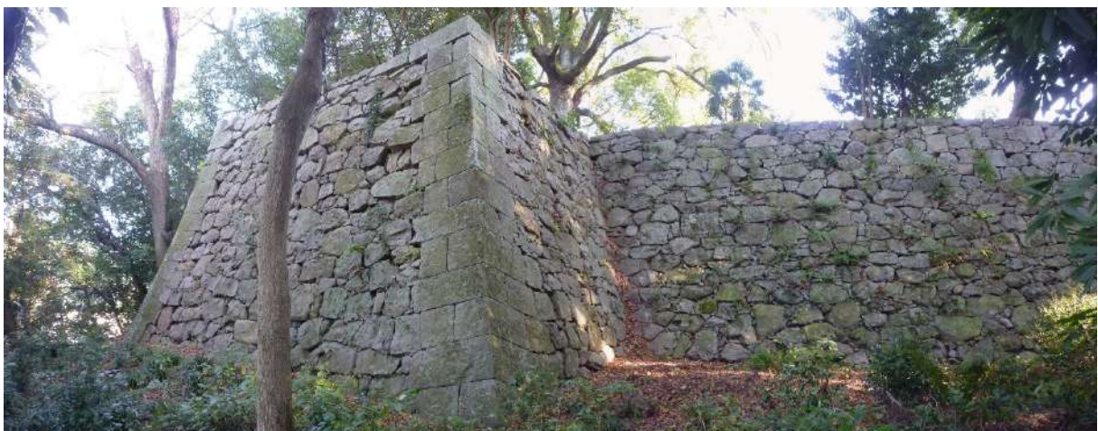
寛文期の改修によって、大規模に改修された長門丸の石垣
