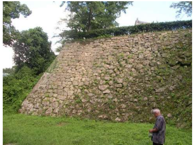
本丸御弓矢倉下の幕末期の改修石垣：修築ラインが明瞭に確認できる
