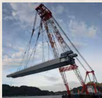
▲架設工事の様子
