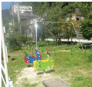
▶公園遊具更新工事
