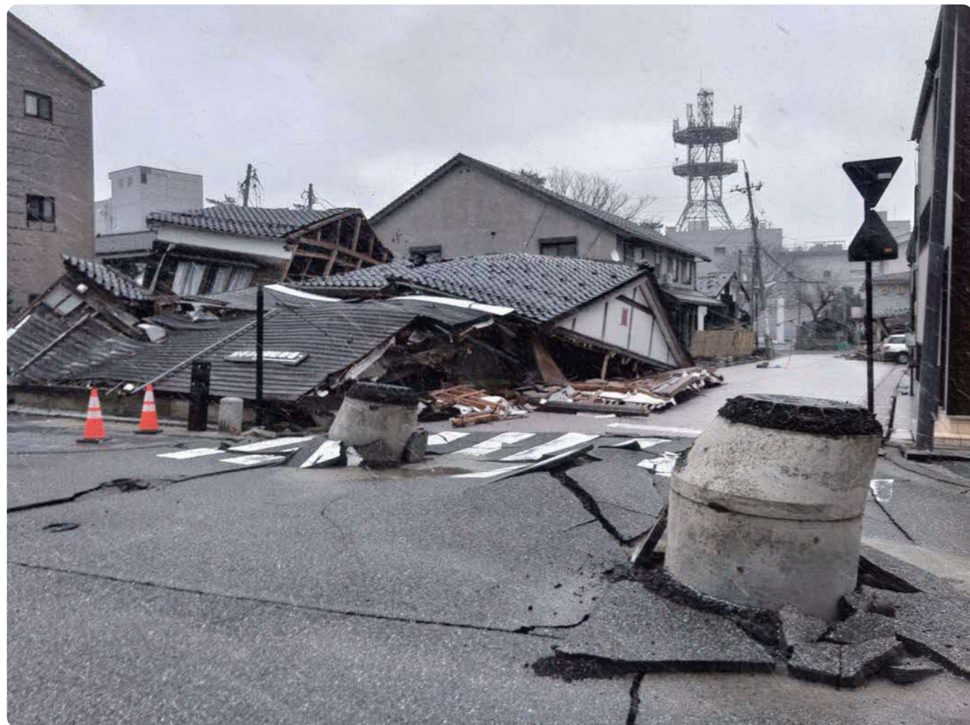
令和6年能登半島地震（令和6年1月1日）発生後の様子
