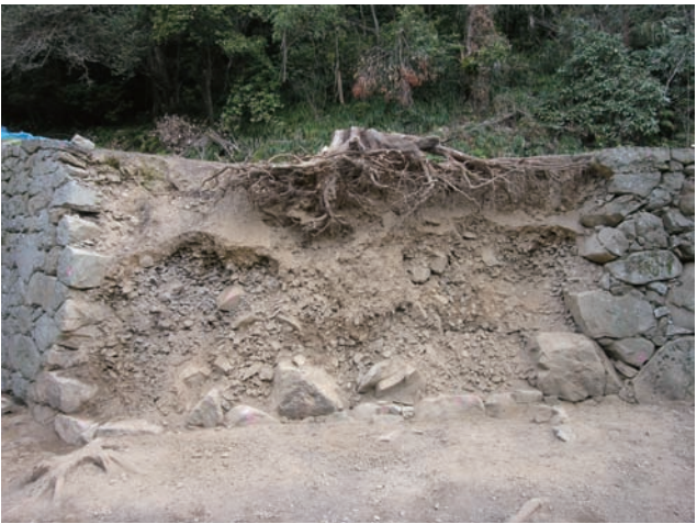
4. 石材整理後の状況
