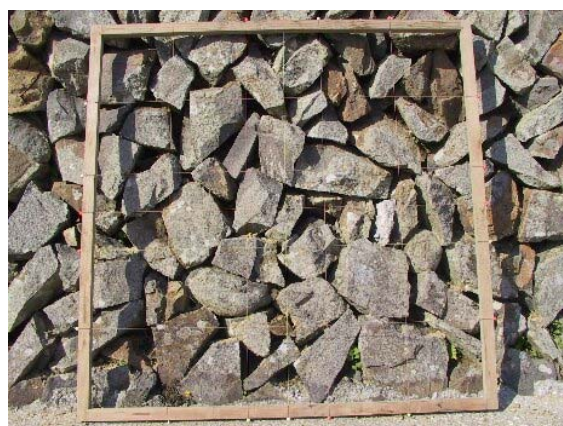
写真 2-Ⅱ-29 石組み状況 4
