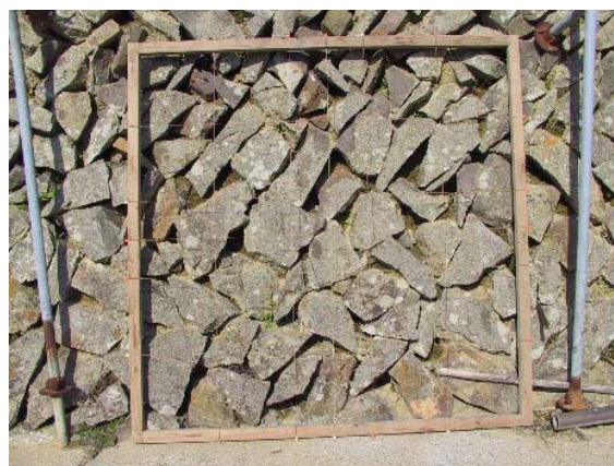
写真 2-Ⅱ-27 石組み状況 2
