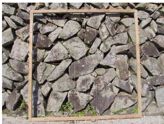
写真 2-Ⅱ-26 石組み状況 1
