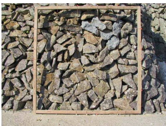
写真 2-Ⅱ-30 石組み状況 5
