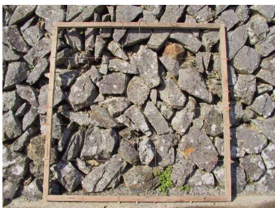
写真 2-Ⅱ-28 石組み状況 3
