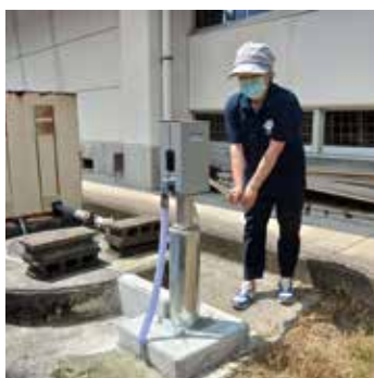
▶ 防災井戸の整備
