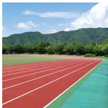
▶ 丸山公園陸上競技場の改修工事
