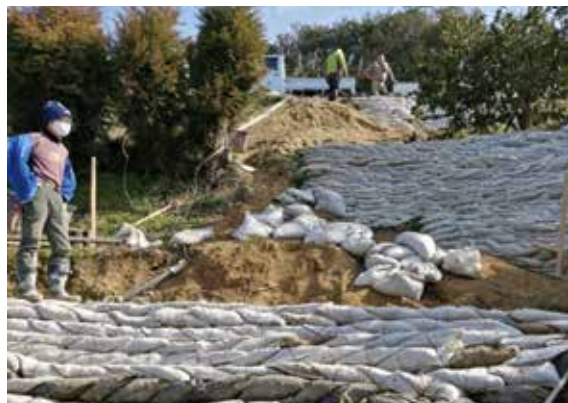
土のうを積み上げ、園地の応急処置を行います
