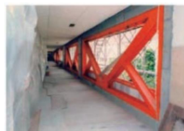
鉄骨ブレースによる壁の補強
