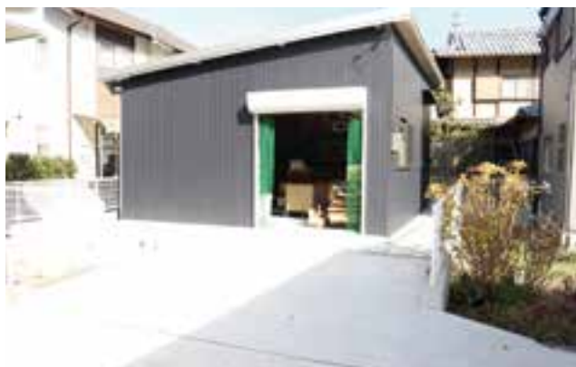
以前より下地を高く建替えた倉庫
