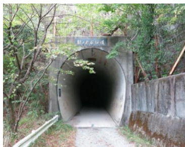
梨ノ木谷隧道
