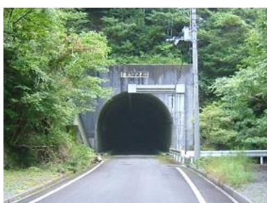
篠山トンネル
