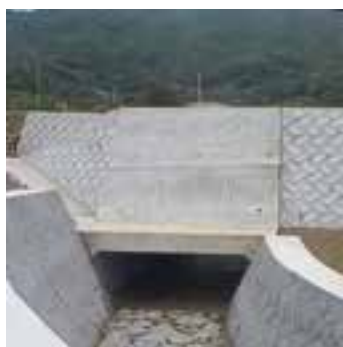
▶ 土木施設災害復旧事業
