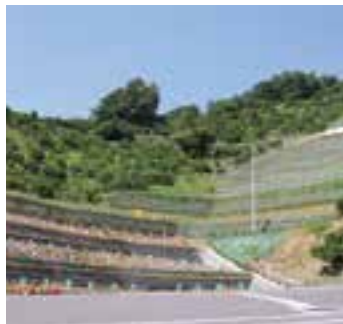
▶ 農地農業用施設災害復旧事業
