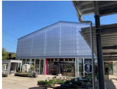
写真. 外観 (旧体育館)
