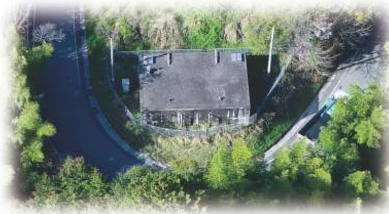
(仕様:RC造100.5m<sup>3</sup>×2池《昭和60年築造》=総有効容量201.0m<sup>3</sup>)
