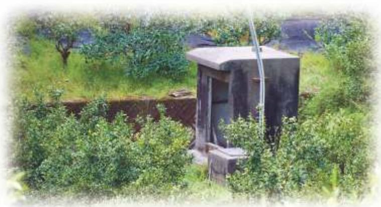
(仕様:RC造4.8m<sup>3</sup>×1池《昭和43年築造》=総有効容量4.8m<sup>3</sup>)
