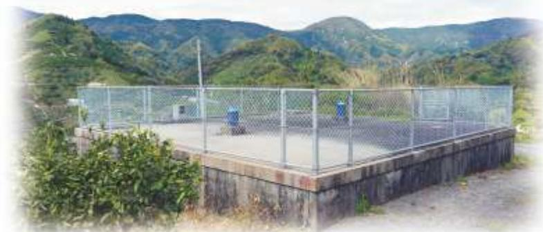
(仕様:RC造98.0m<sup>3</sup>×1池《昭和29年築造》+RC造102.5m<sup>3</sup>×2池《昭和57年築造》=総有効容量303.0m<sup>3</sup>)
