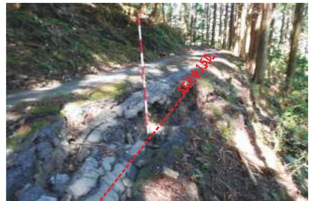
路肩損壊に伴う配水管の損傷(津島地域)
