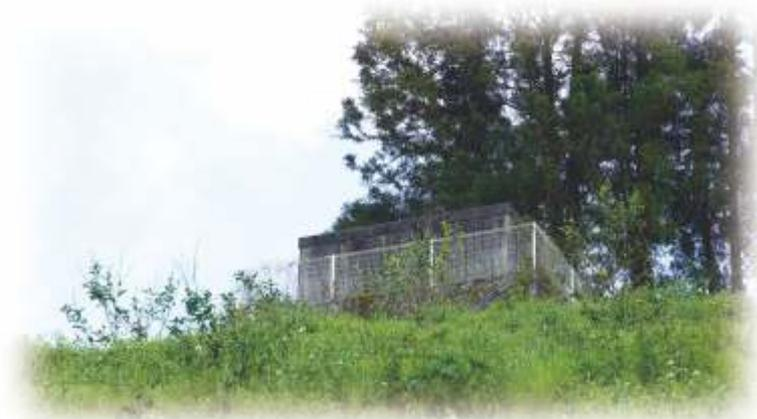
(仕様: RC造43.0m<sup>3</sup>×1池《平成4年築造》=総有効容量43.0m<sup>3</sup>)
