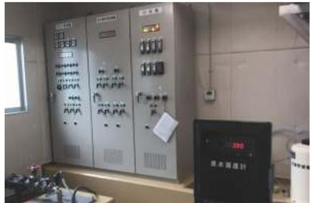
高濁度表示の長谷浄水場原水濁度計(吉田地域)
