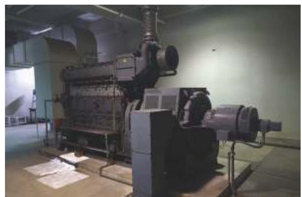
柿原浄水場の老朽化した既設自家発電装置
