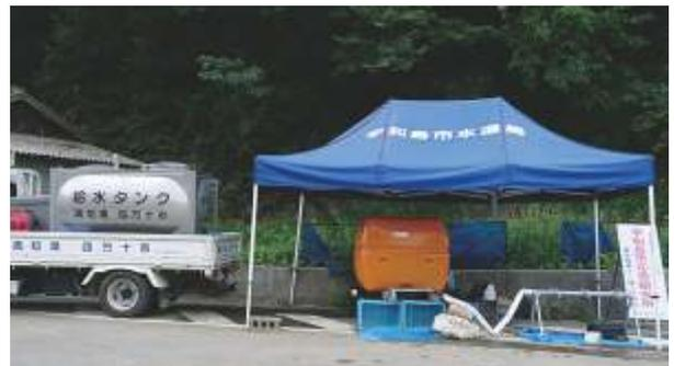
蛇口付き給水架台セットを設置した応急給水所
