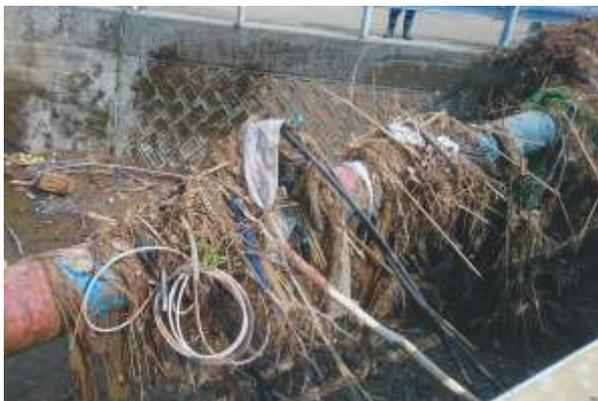
水管橋へのゴミ堆積と空気弁損傷(吉田地域)
