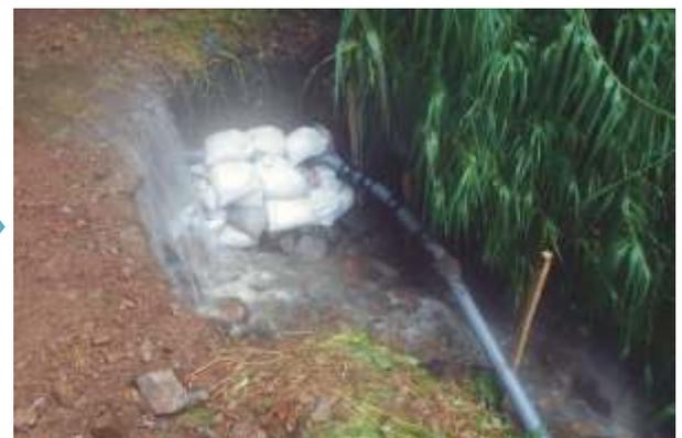
地盤洗掘に伴う配水管損傷と応急復旧(津島地域)
