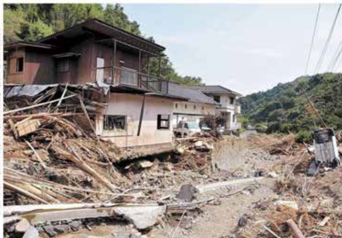
道路が壊れるなど深刻な被害を受けた奥白井谷地区 18日午後2時15分ごろ、宇和島市吉田町立間
