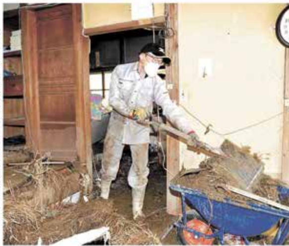
民家から土砂をかき出す作業をする嶋崎祐太さん 16日午後、宇和島市吉田町立間
