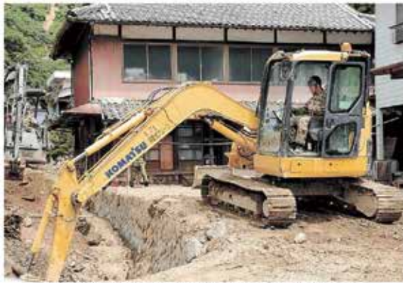
土砂が住宅地に流れ込んだ現場では重機を使った復旧作業が行われている—22日午前、宇和島市吉田町立間（撮影・森岡岳夢）
