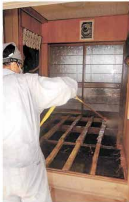
床上浸水した家屋の消毒作業を実施する業者 ＝26日午後、宇和島市吉田町西小路
