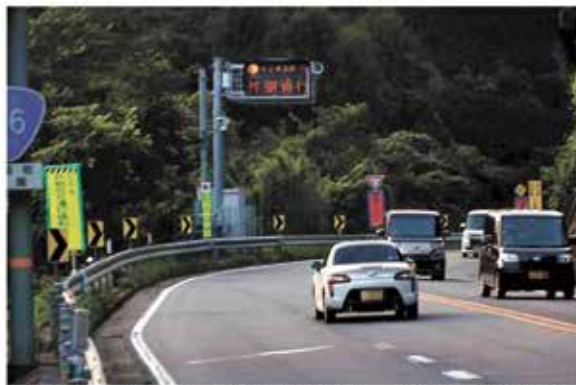
通行が可能となった国道56号。電光掲示板はトンネル内の片側通行を示している＝16日午後6時55分ごろ、宇和島市吉田町立間（撮影・宇和上翼）
