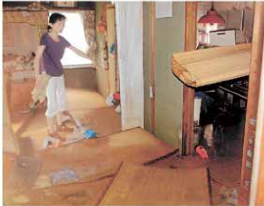
大雨で床上浸水した家。壁が浮き上がり家財道具が散乱していた。7日午後4時20分ごろ、宇和島市吉田町神村（撮影・宇和上翼）
