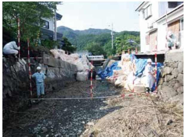
漁港施設等の災害調査の様子
