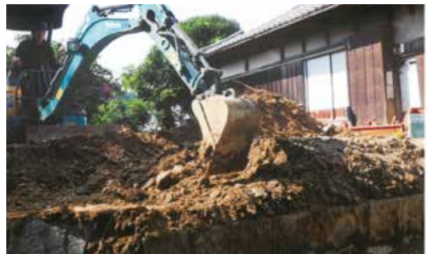
宅地内の土砂撤去の様子
