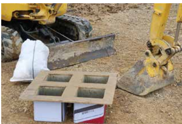
一度に4袋の土のうを作る仕組みを考案するなど試行錯誤が続けられた
