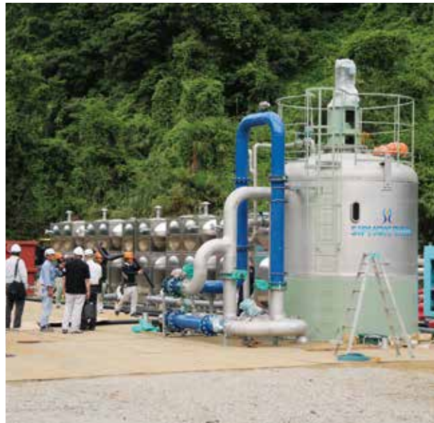
吉田地区に建設された仮設浄水設備
