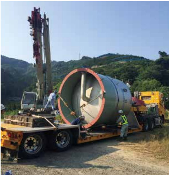
仮設浄水設備建設地に運び込まれた大型浄水装置
