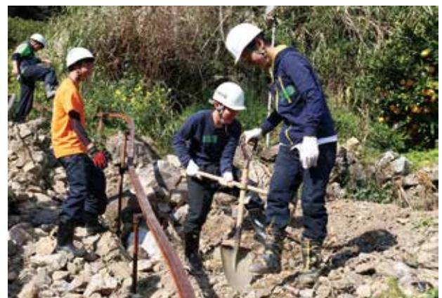
ほかにも、園地に流れ込んだ瓦礫などの撤去作業を行った
