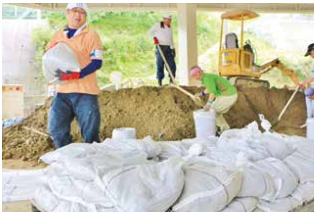
JA玉津共選場で土のう作りに汗を流す (JAえひめ南提供)
