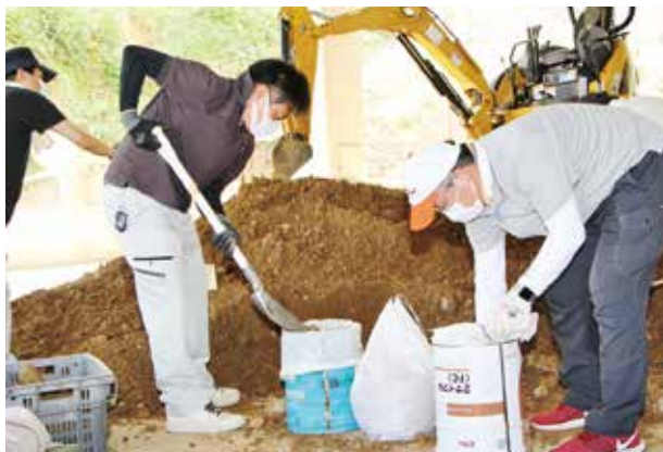
1,000袋作っても1~2日でなくなってしまう土のう不足は長期間にわたって続いた (JAえひめ南提供)
