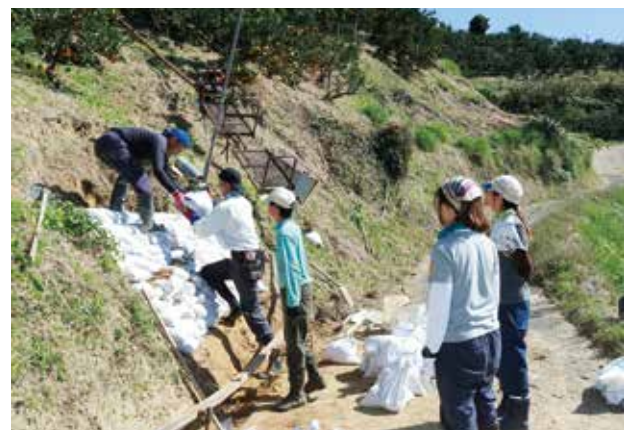
崩れた園地の復旧作業のため大量の土のうが必要とされた
