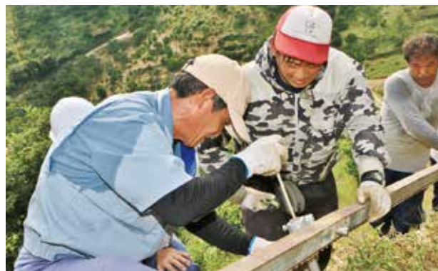
平成30年9月に行われたモノレール復旧のための現地講習会 (JA えひめ南提供)
