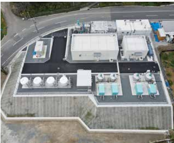
吉田仮設浄水場（令和2年10月26日給水開始、令和3年3月12日整備完了） （南予水道企業団提供）
