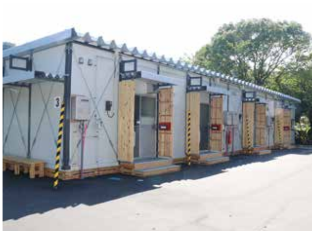
鉄骨プレハブ平屋の長屋形式3棟、延べ床面積計約360㎡の建設型仮設住宅が吉田支所隣の公園に建てられた
