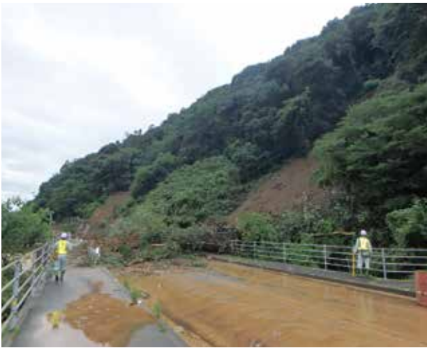
落ちてきた土砂が車線を塞ぎ、同時に大量の泥水が道路を流れる (国土交通省 四国地方整備局提供) 国道56号(立間)
