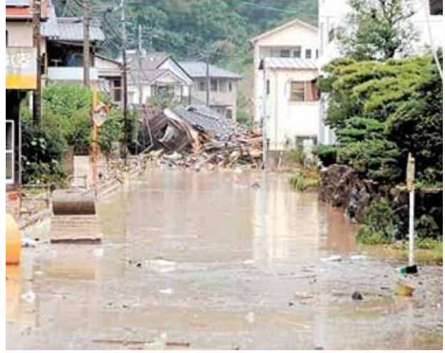
斜面の崩落が連続して家屋が倒壊し、道路をふさいでいる (愛媛新聞：平成30年7月8日)
