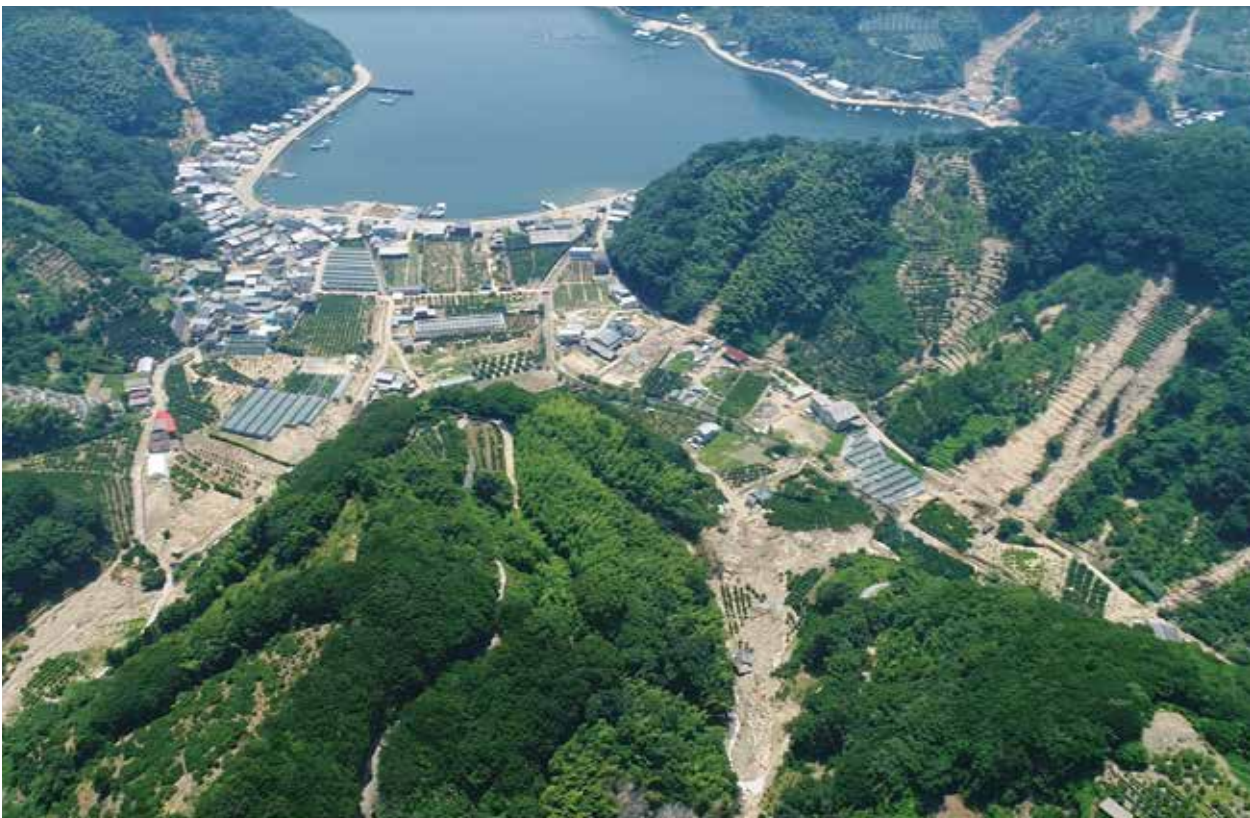
ドローンでの空撮。あちこちで土砂崩れが発生していることが分かる
