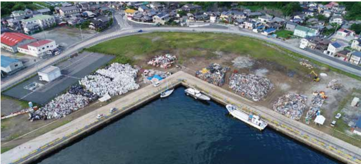
1.5次仮置場となった大浦埋立地
