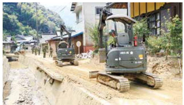
自衛隊が各地で道路啓開作業を実施 (自衛隊提供)
